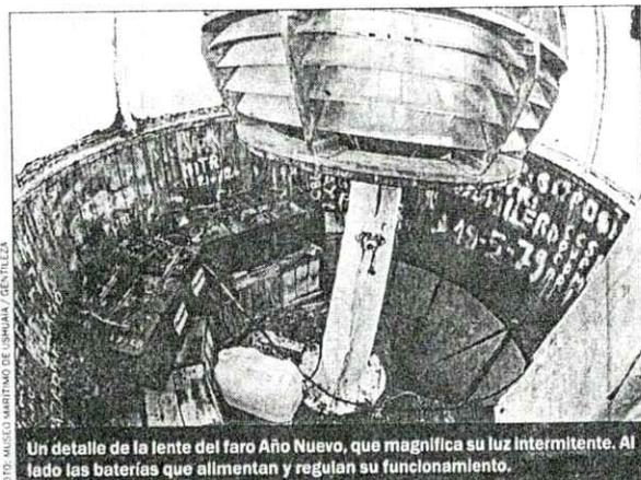
Un detalle de la lente del faro Año Nuevo, que magnifica su luz intermitente. Al lado las baterías que alimentan y regulan su funcionamiento.
